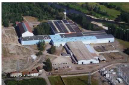
Usine de Vincey
